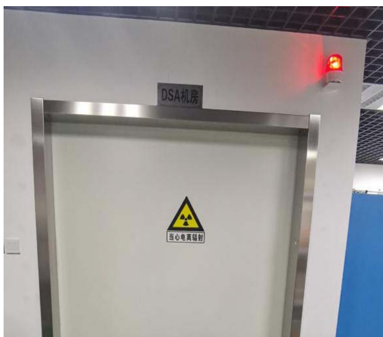
机房门口电离辐射警示，警示灯，与防护门关联
